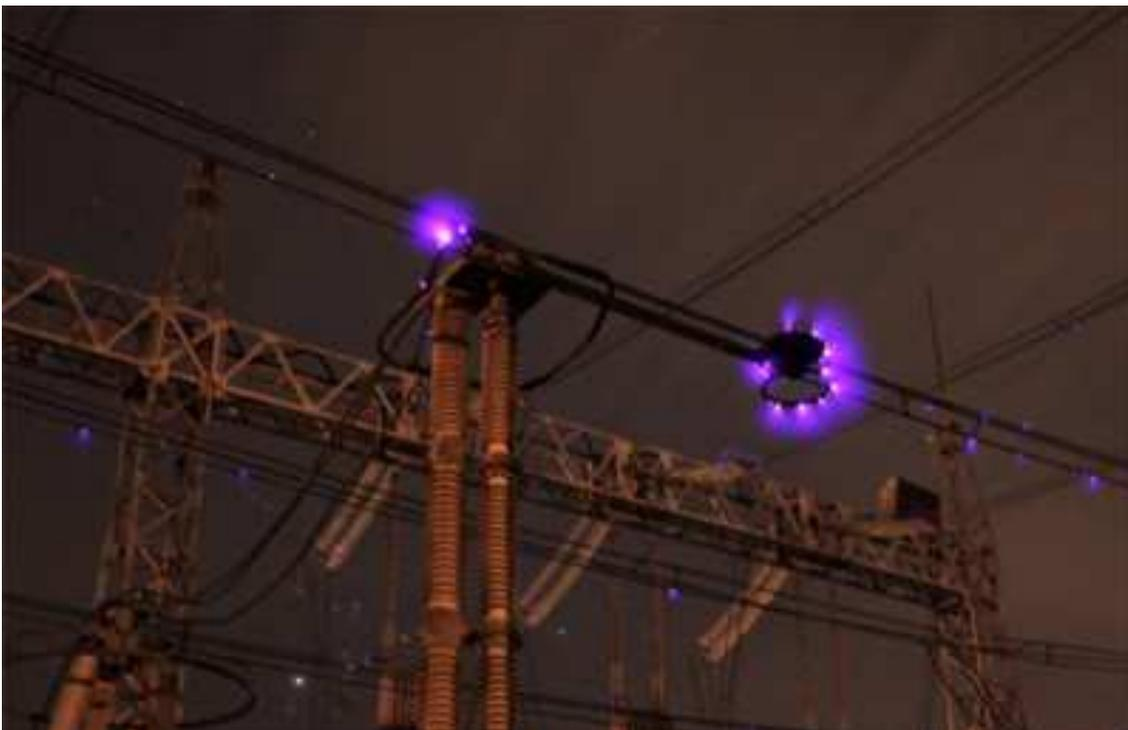
Рис. 3-3-2. Токи утечки во влажном воздухе.
