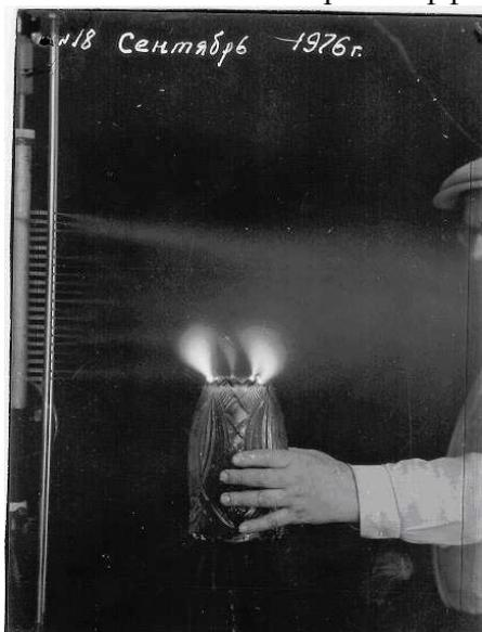
Рис. 3-3-4. Богдан Войцеховский демонстрирует эффект образования огней святого Эльма в своей лаборатории. Слева виден генератор капельного облака, в которое введена ваза.
