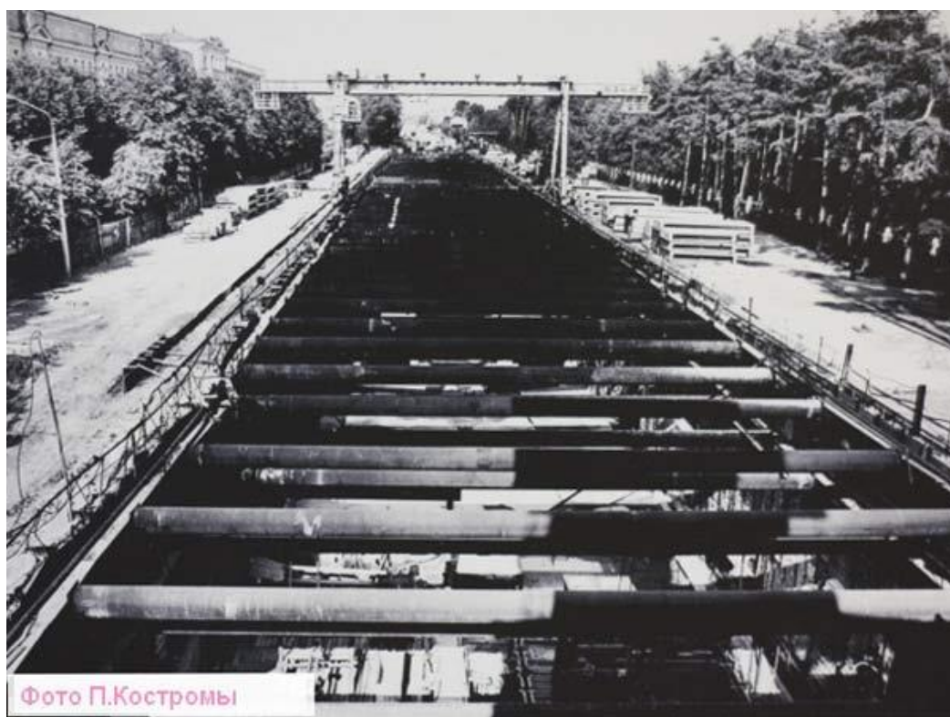
Строительство линии метро возле парка Челюскинцев
