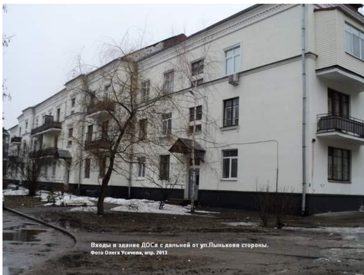
Входы в здание ДОСа с дальней от ул. Лынькова стороны
