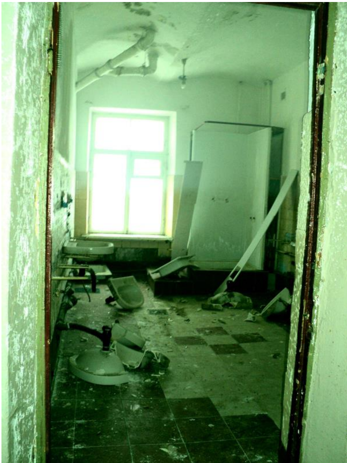
3-7-4 Помещение на 1 этаже правой половины здания казармы, 16.01.2016
