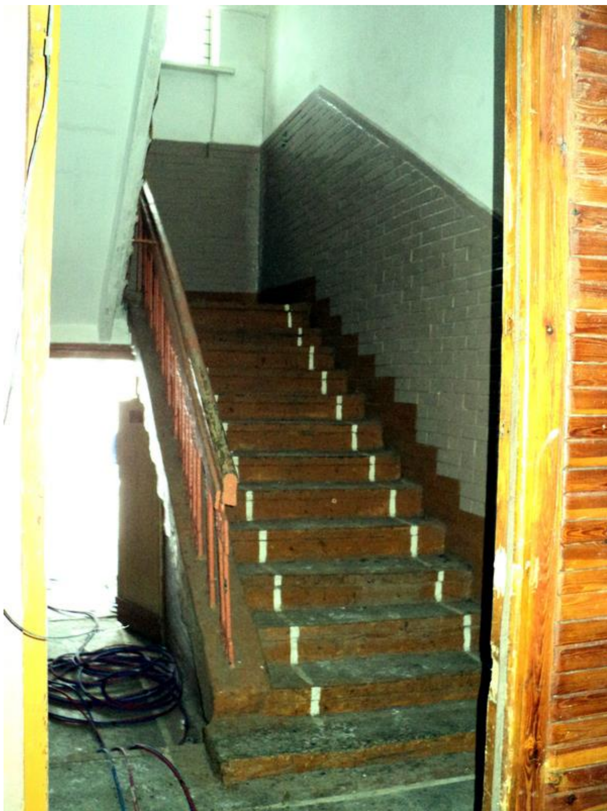
3-6-1 Лестница с 1 на 2 этаж, правая половина здания казармы, слева вход в здание, 16.01.2016
