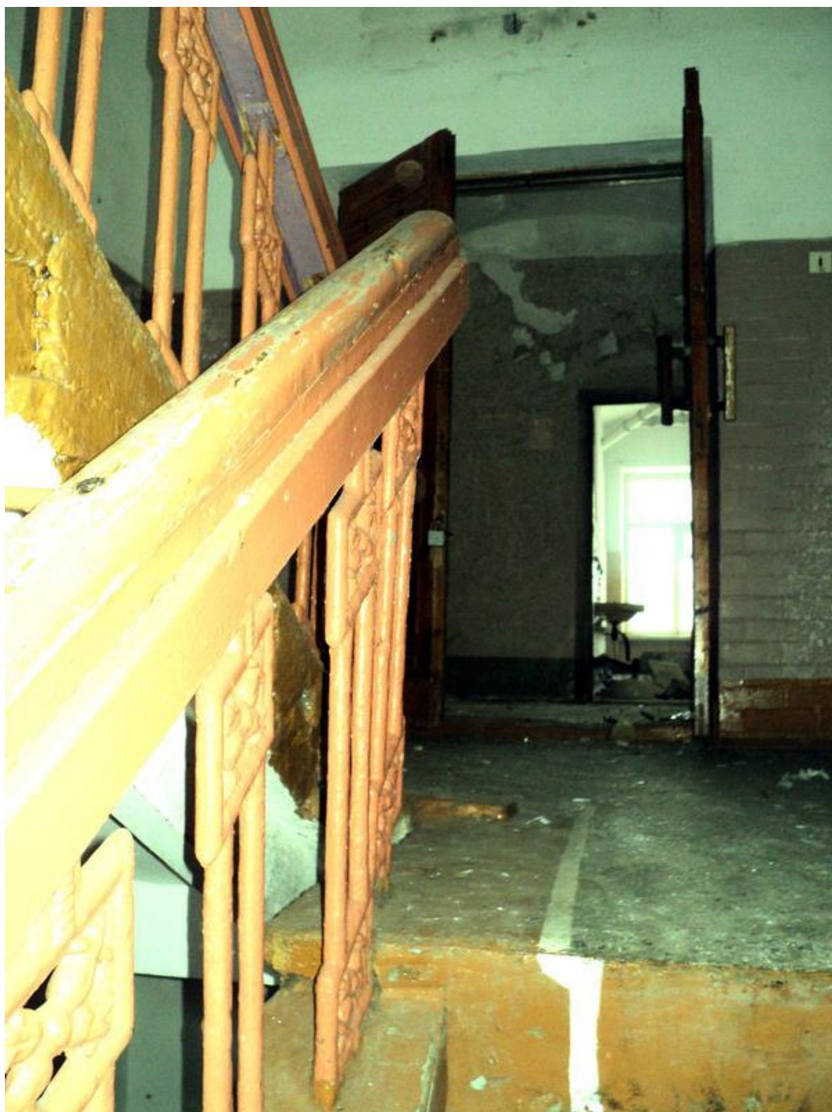
3-6-3 Вход на 2 этаж правой половины здания казармы, 16.01.2016
