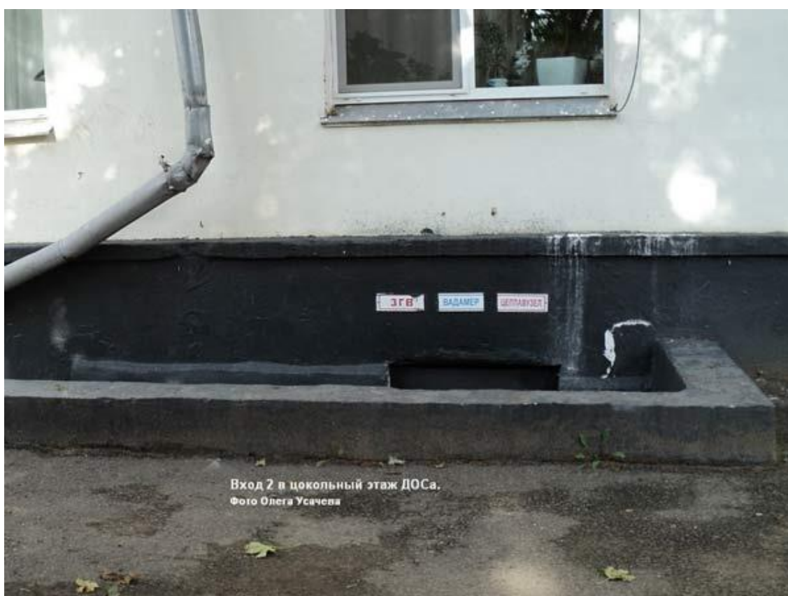
Вход 2 в цокольный этаж здания ДОСа
