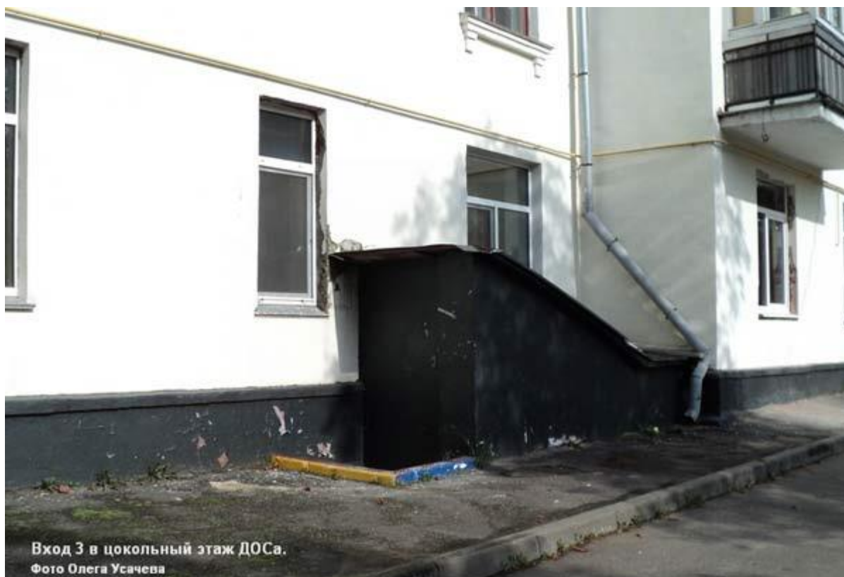
Вход 3 в цокольный этаж здания ДОСа
