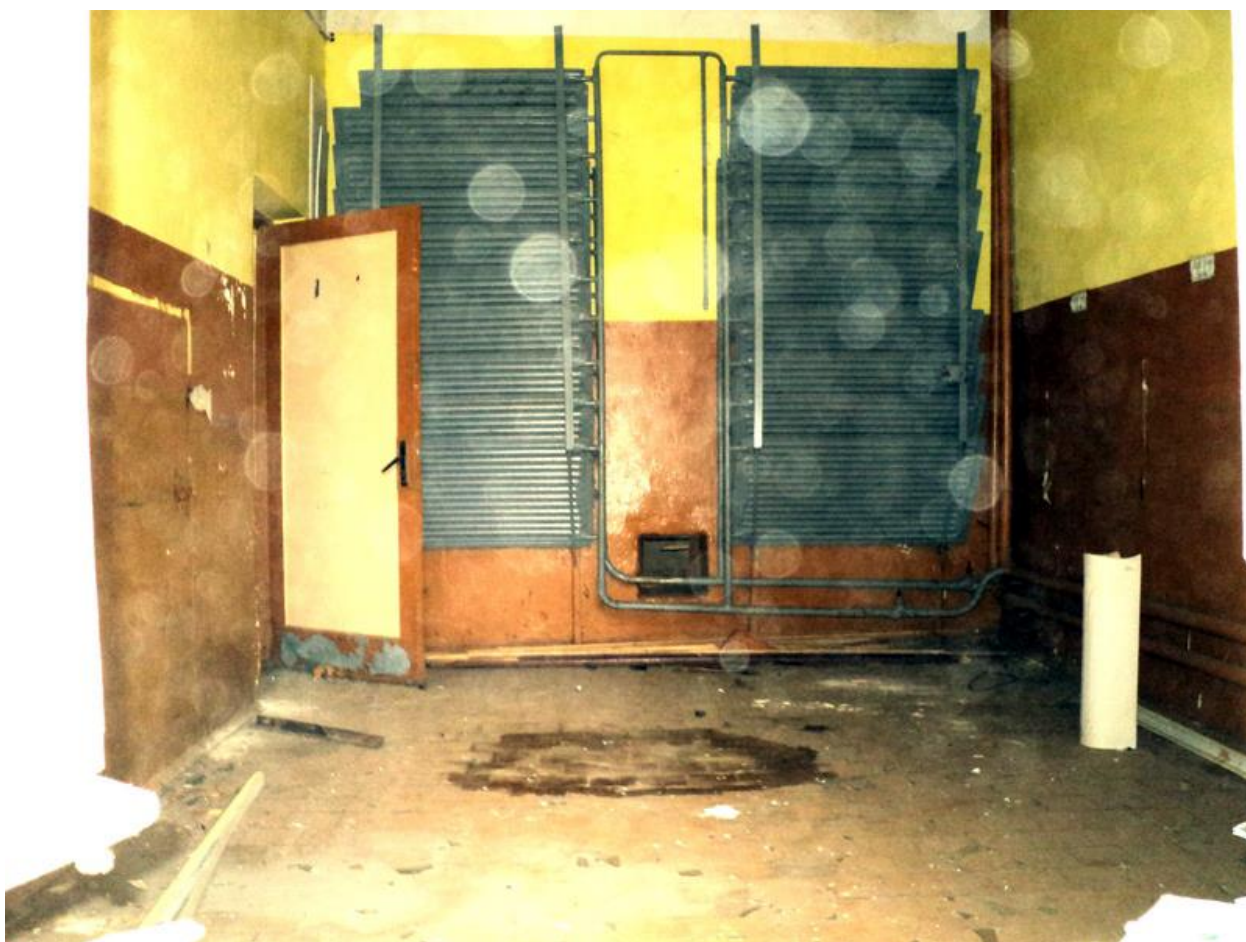
Сушилка в левой половине цокольного этажа казармы, 25.10.2015
