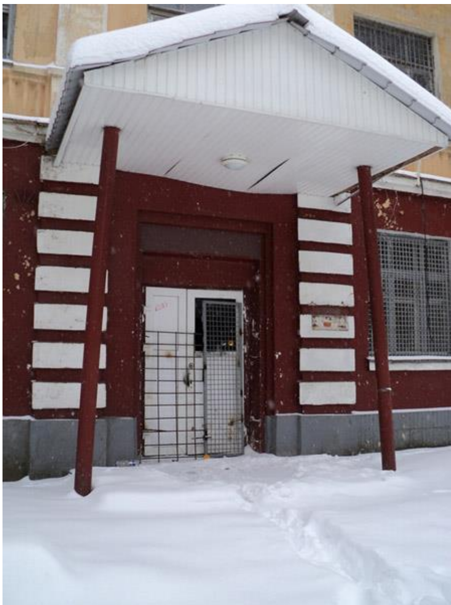
2-20-8. Вход в левую половину здания казармы, 16.01.2016
