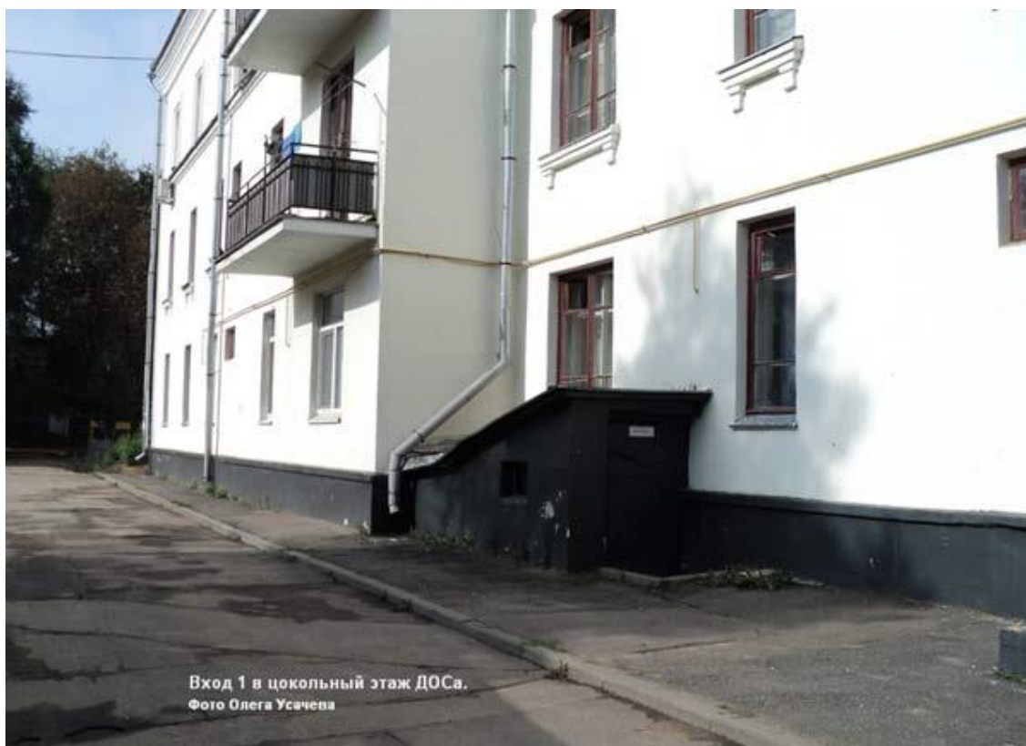
Вход 1 в цокольный этаж здания ДОСа
