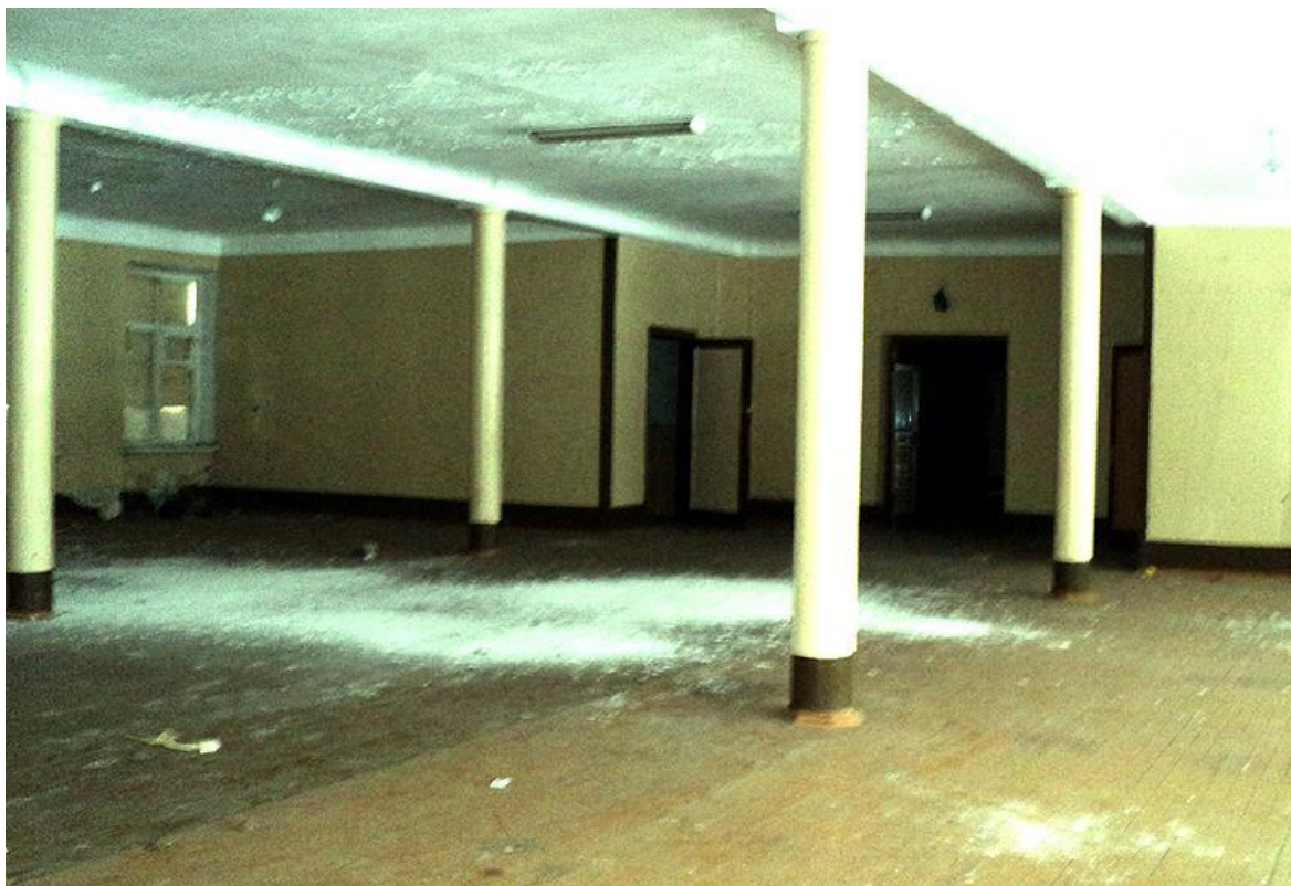
3-7-12 Большое (на всю ширину здания) помещение на 1 этаже правой половины здания казармы, 16.01.2016
