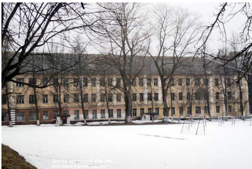
Вид на казарму с тыльной стороны
