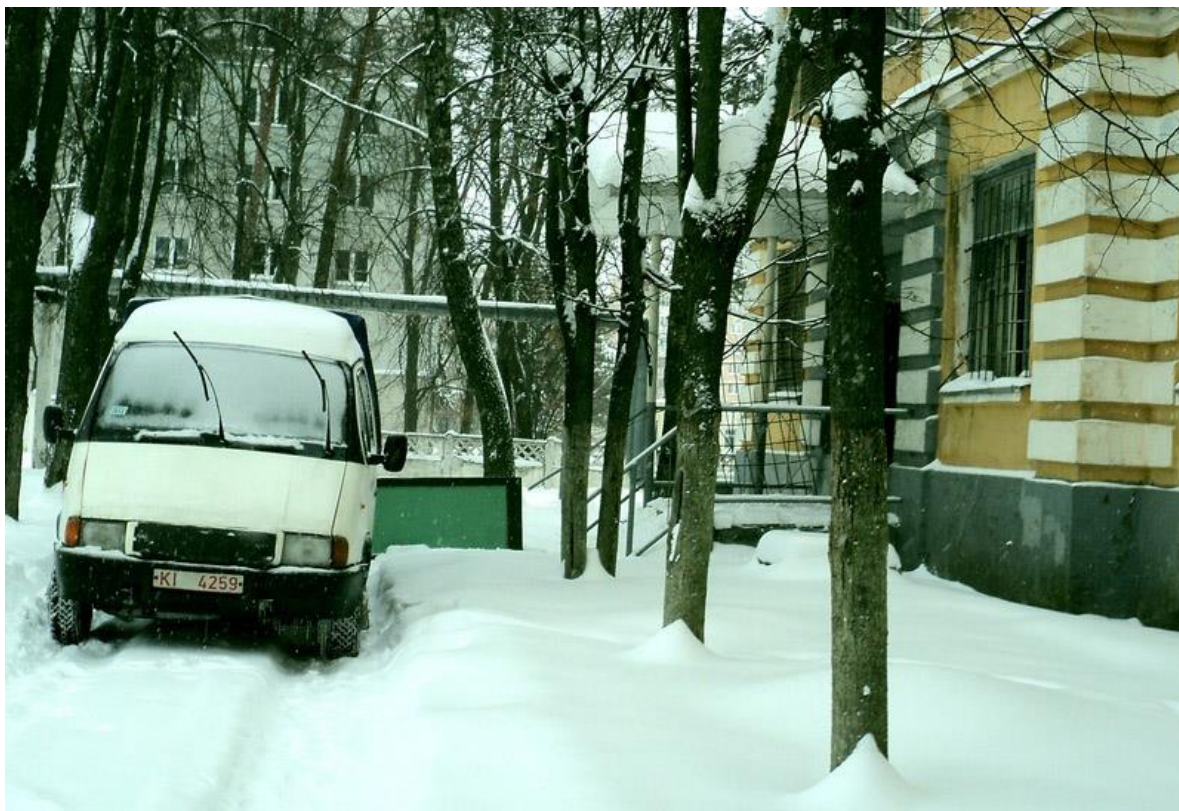
2-20-9. У входа в правую половину здания казармы, 16.01.2016
