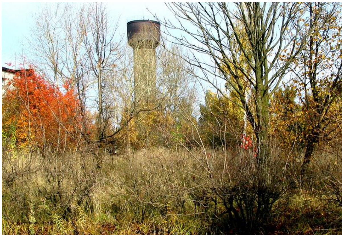
Водонапорная башня возле кладбища, 25.10.2007
