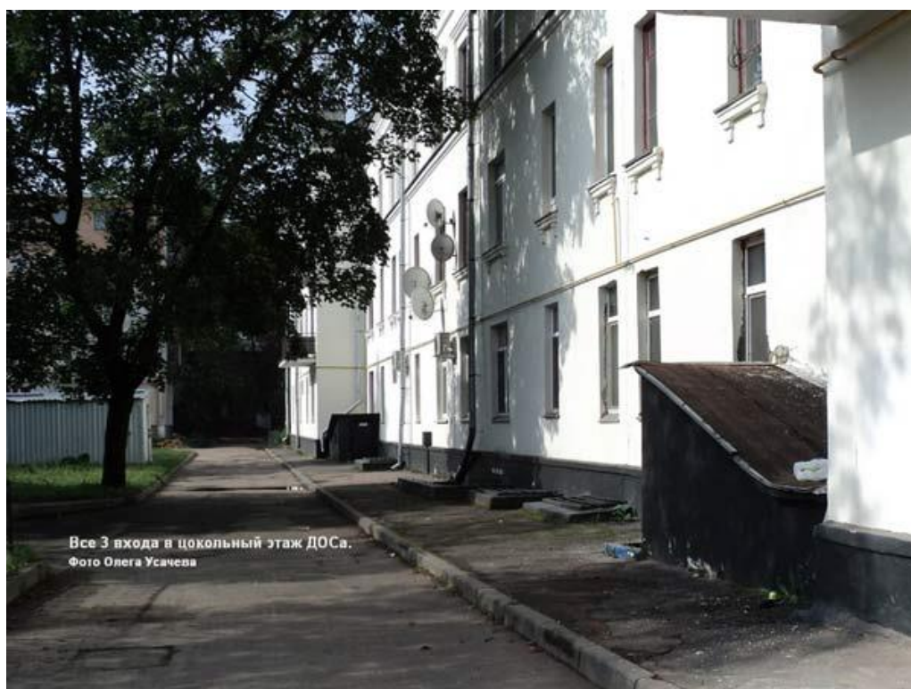
Все 3 входа в цокольный этаж ДОСа
