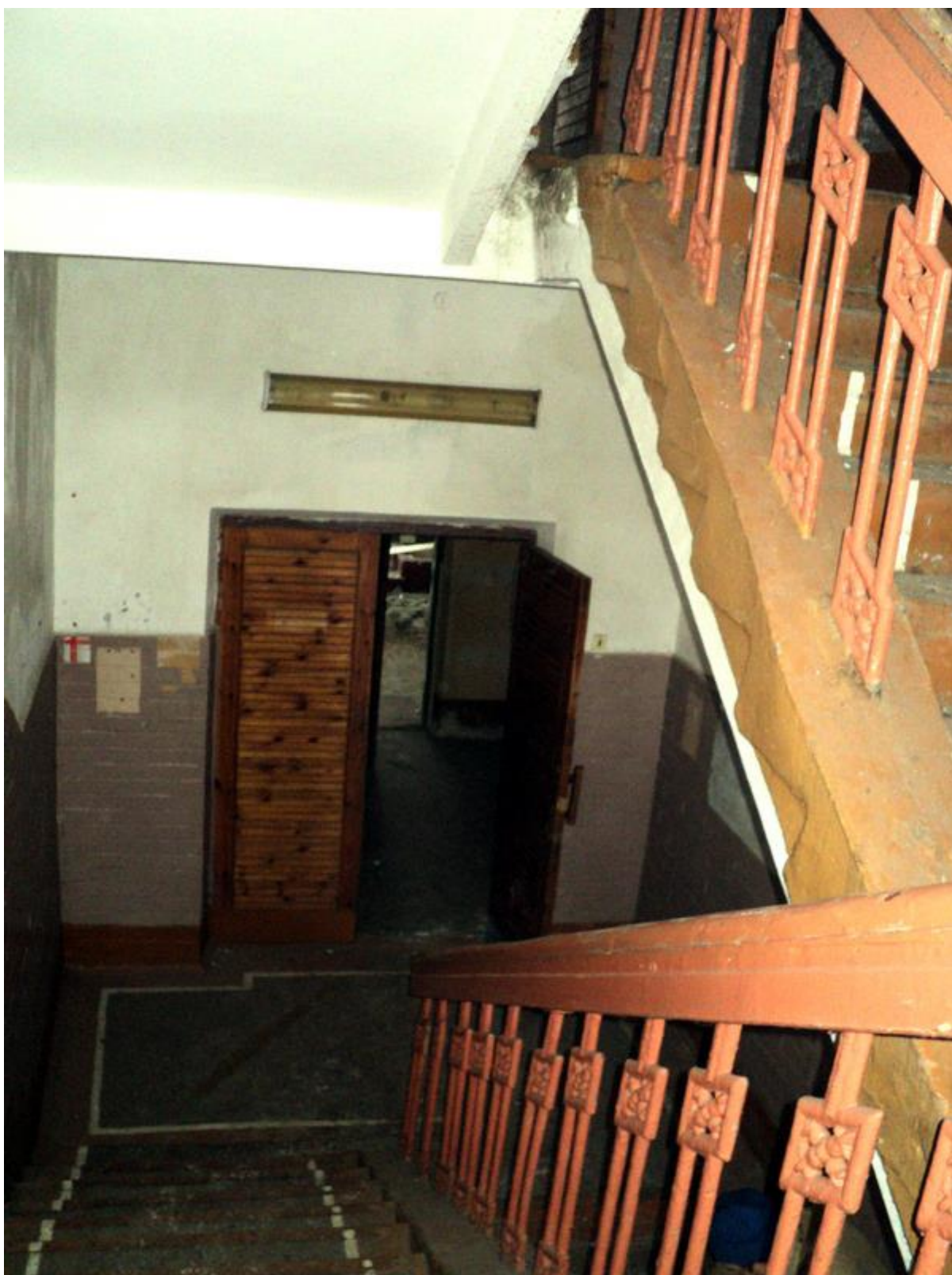
3_6_2_Вход в здание и лестница ,_правая половина здания казармы, 16.01.2016
