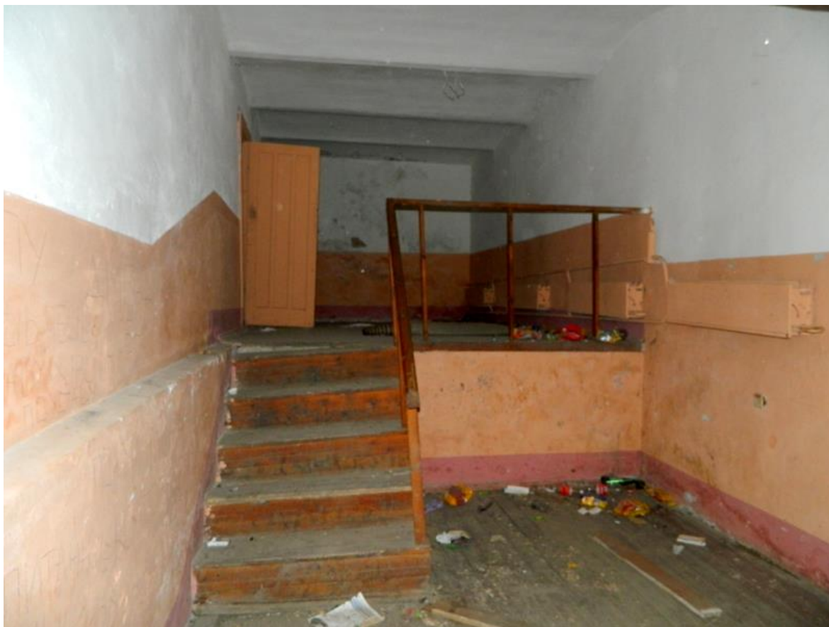
Дверь прохода (из большого козырька) в цокольный этаж левой половины казармы, 2014
