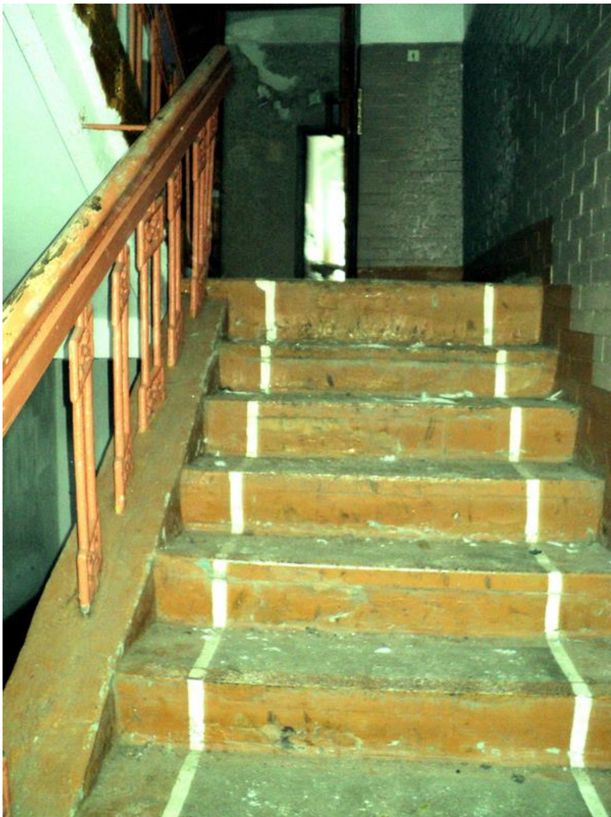
3-6-4 Лестница на 2 этаж правой половины здания казармы, 16.01.2016
