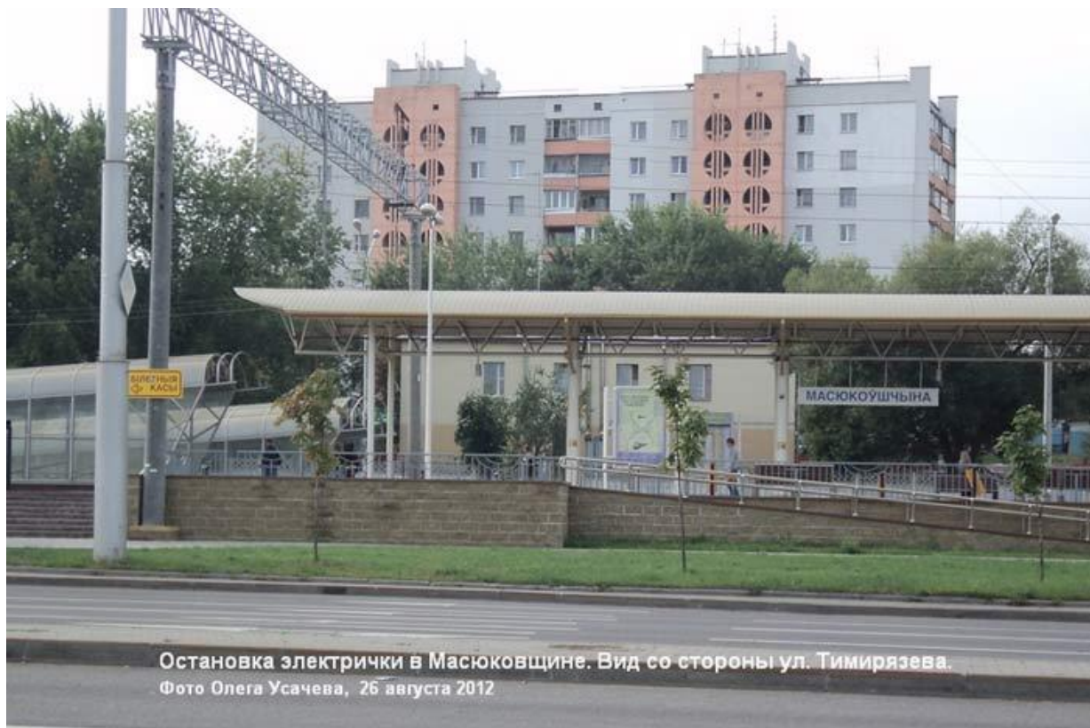
Остановка электрички у бывшего ж/д переезда. Вид с ул. Тимирязева (2012)
