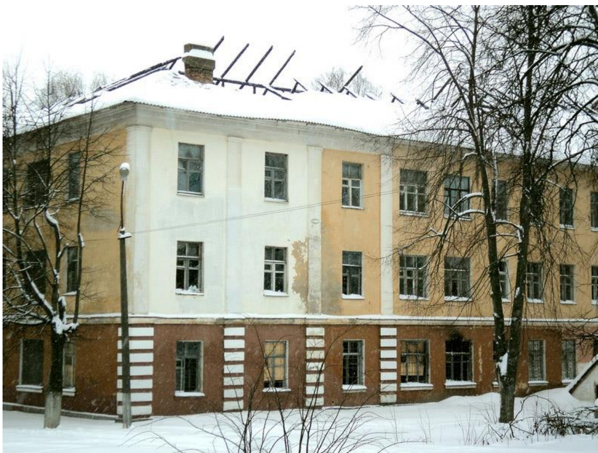
2-20-1. Сгоревшая крыша в левой половине здания казармы, 16.01.2016
