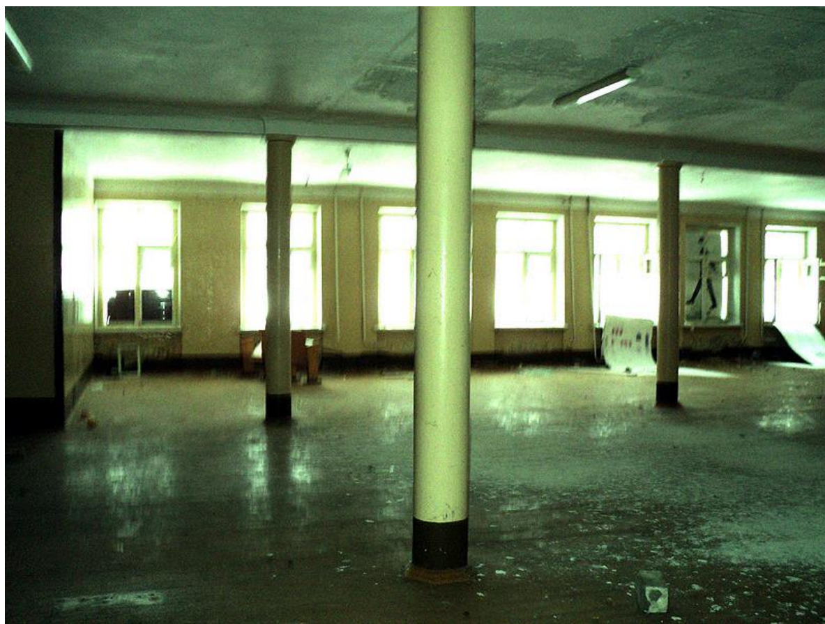
3-7-13 Большое помещение на 1 этаже правой половины здания казармы, 16.01.2016
