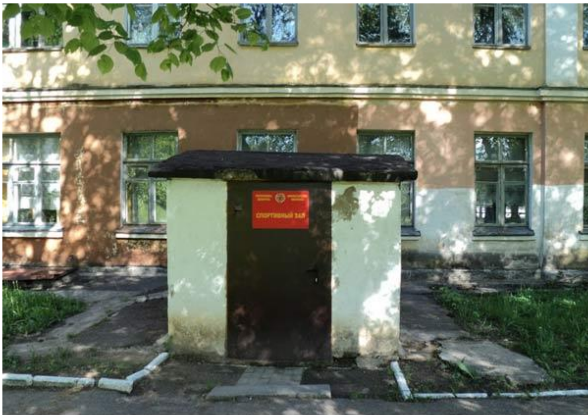
Военный городок в Масюковщине. Сохранившееся здание довоенной казармы. Вход в спортзал в цокольном этаже казармы. Фото Олега Усачева. 9 мая 2012
