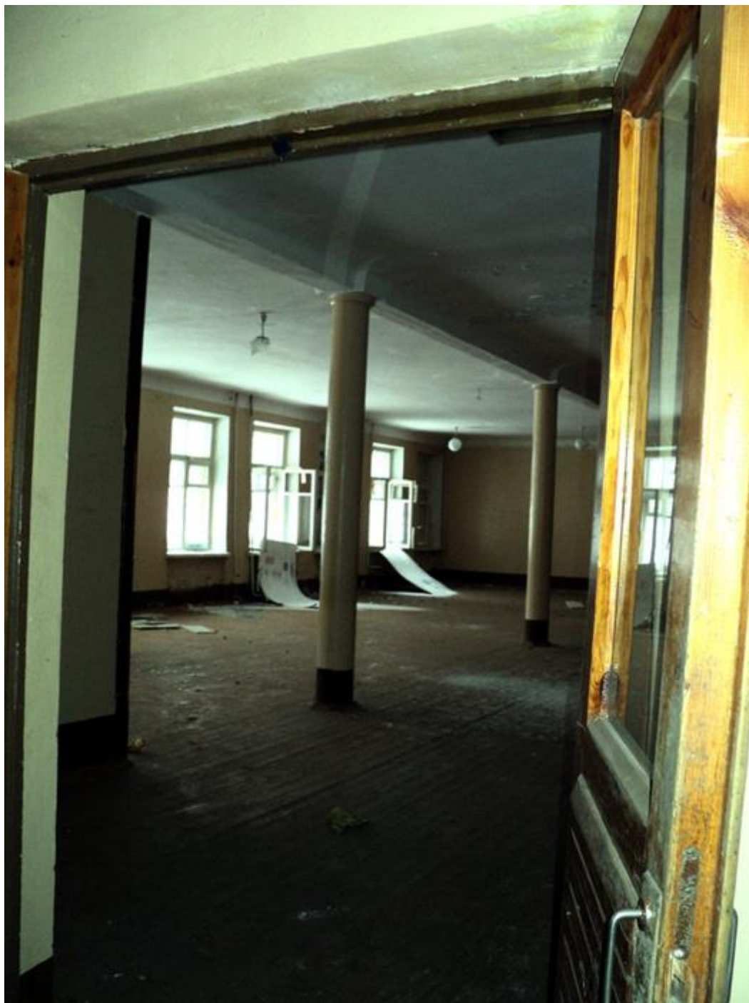
3-7-10 Вход в большое (спальное) помещение на 1 этаже правой половины здания казармы, 16.01.2016
