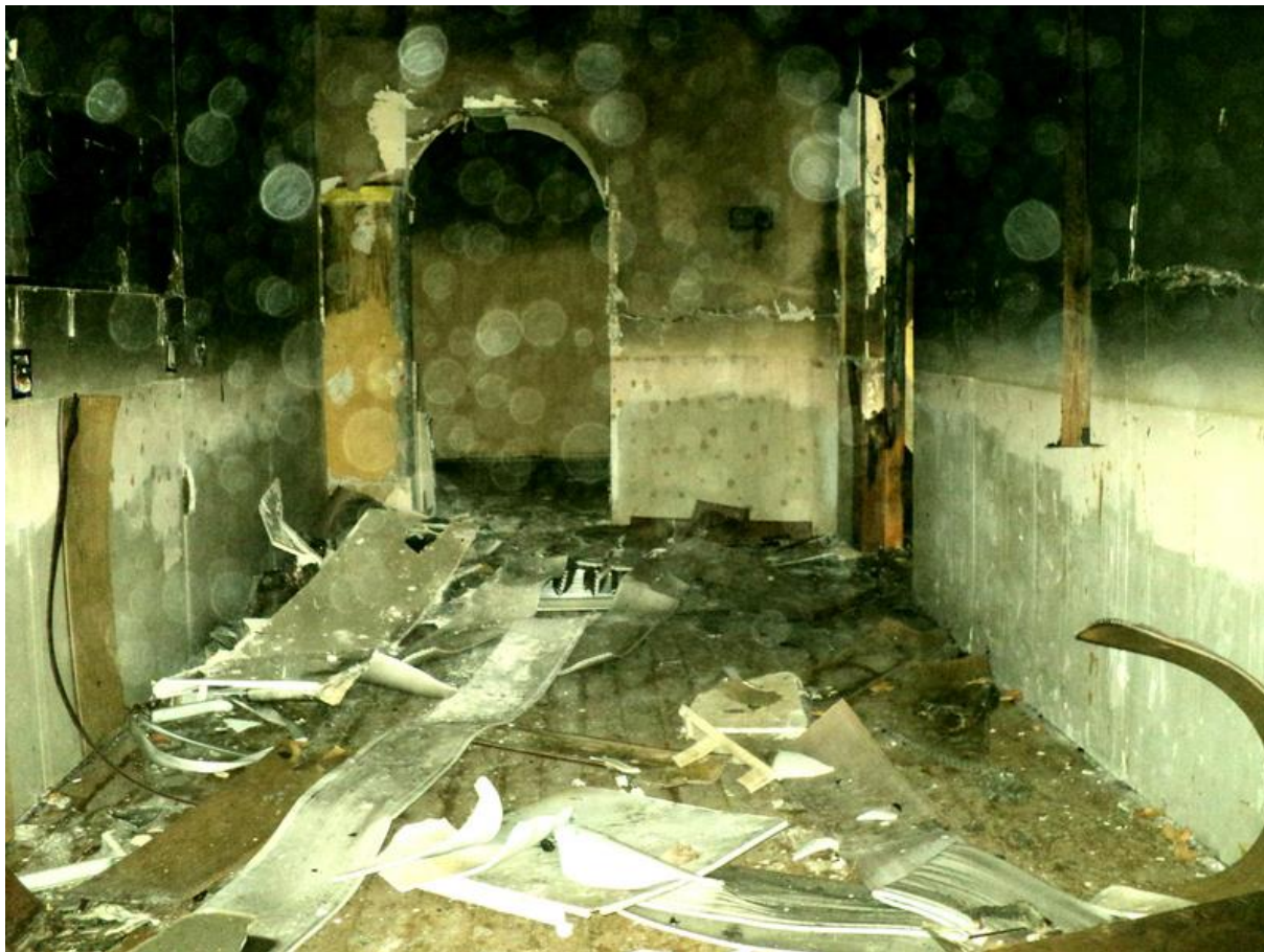
3-2-2 Помещение на 1 этаже левой половины здания казармы, 25.10.2015
