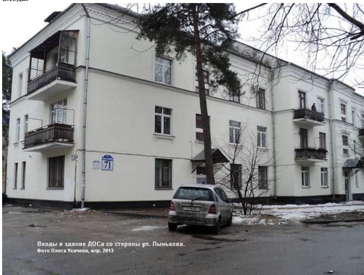
Входы в здание ДОСа со стороны ул. Лынькова
