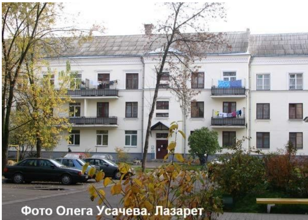
Здание бывшего Дома офицерского состава (ДОС) и лагерного лазарета
